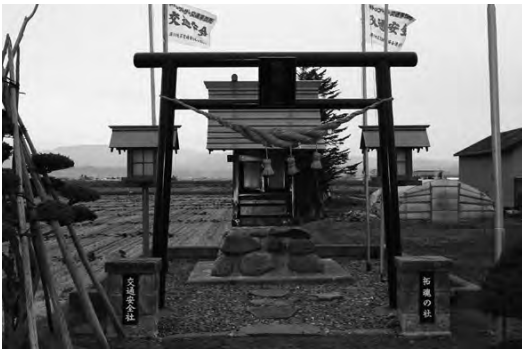
拓魂の社（解体前）
