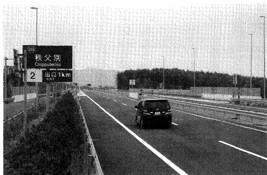
一部開通した高規格幹線道路の深川留萌自動車道
