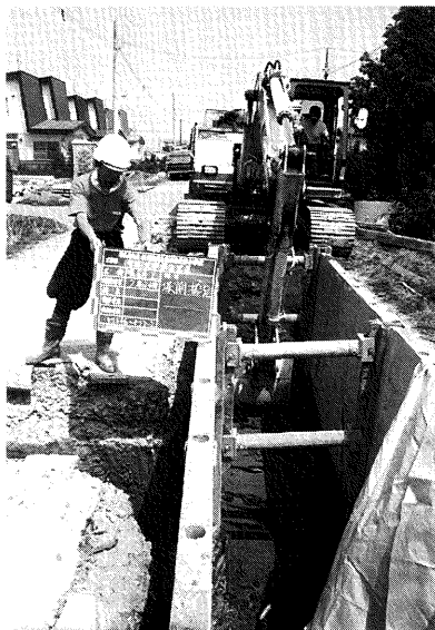
下水道整備工事 兵村団地（平成元年7月24日）
