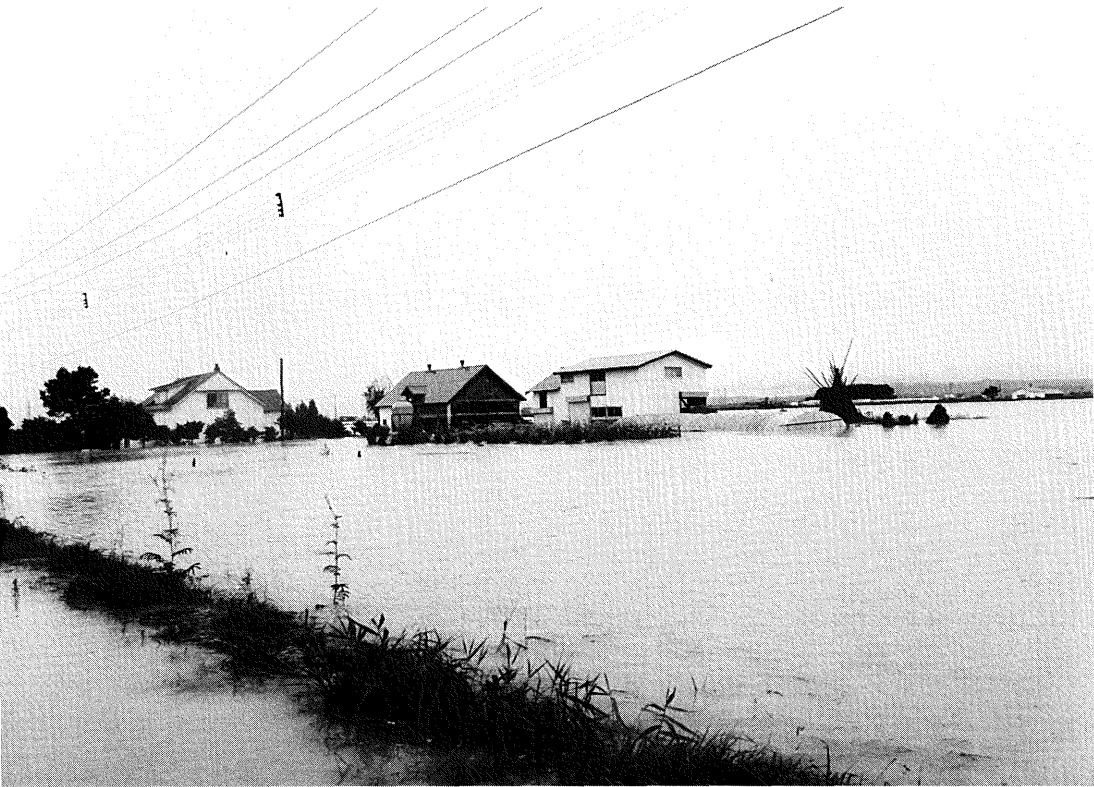
集中豪雨により河川、用水路氾濫（昭和63年8月26日撮影・2条2丁目）
