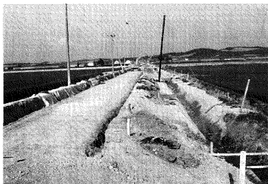
農村道路の改修工事 9条通り（昭和63年頃）
