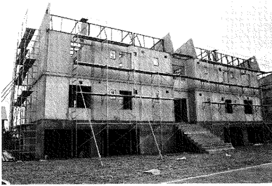
建設中の町営住宅中央西C団地（平成2年9月中旬）
