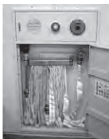
屋内消火栓設備
